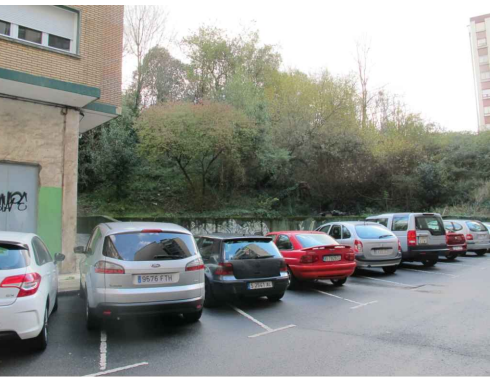
2. Fondo de ladera sobre calzada
