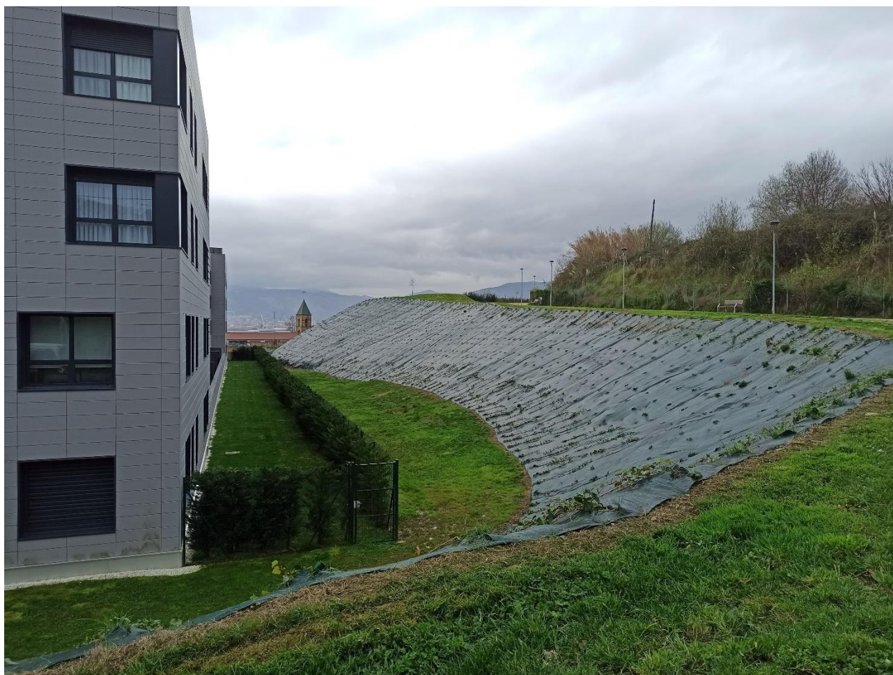
Imagen 16. Talud cubierto por geotextil perforada en proceso de plantación entre Leioagoitia y Aldekoena.
